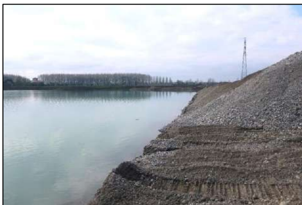
Vue de l'extraction Source : Artifex 2021
